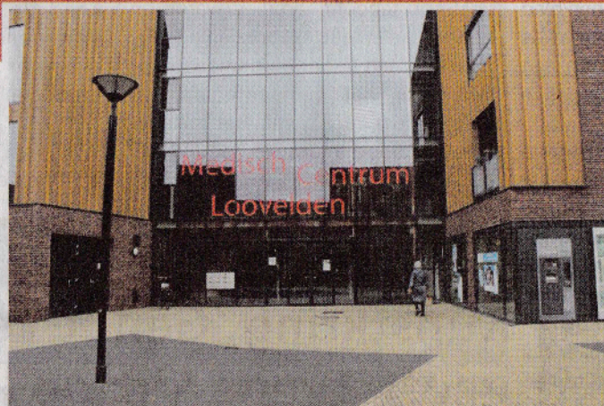
De uitnodigende ingang van Medisch Centrum Loovelden is vanaf de straat niet te zien!
